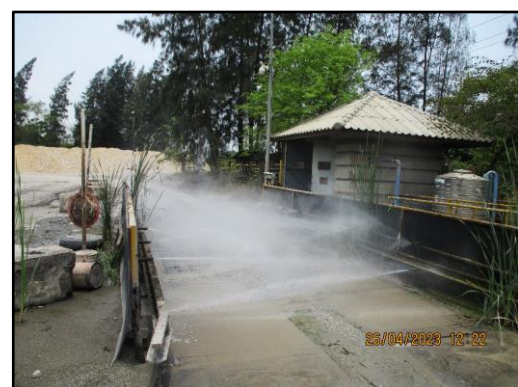
ภาพที่ 2.21 จุดล้างล้อรถบรรทุกบริเวณด้านลิง
