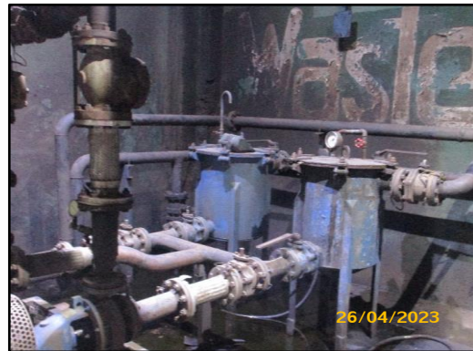
ภาพที่ 2.15 ระบบสูบน้ำกลับเข้า Silo
