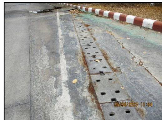
ภาพที่ 2.19 ระบบรางระบายน้ำแบบตะแกรงปิด
