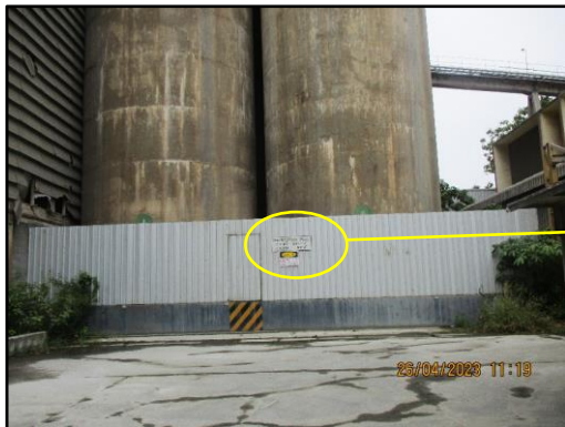
ภาพที่ 2.16 Bund Wall โดยรอบ Silo ของเสียที่เป็นของเหลว
