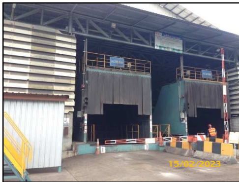
ภาพที่ 3.68 การทำ Hood คลุมอ่างเทเชื้อเพลิง
