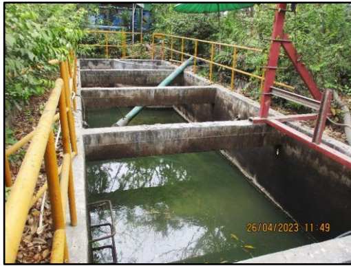
ภาพที่ 2.17 บ่อดักไขมันและน้ำมันพร้อมถังบรรจุไขมันขนาด 200 ลิตร
