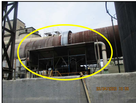
ภาพที่ 3.106 ฉากป้องกันความร้อนบริเวณ Riser pipe
