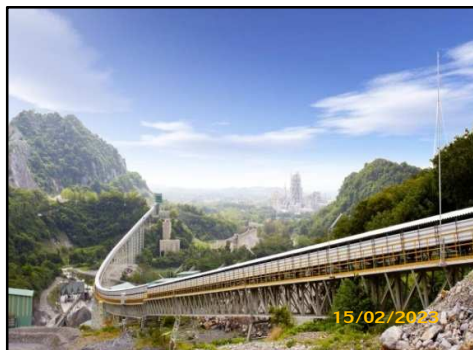
ภาพที่ 3.69 หลังคาครอบสายพานลำเลียงวัตถุดิบและเชื้อเพลิง
