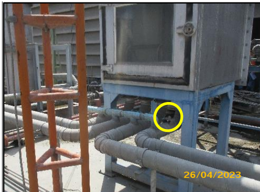
ภาพที่ 2.12 วาล์วที่ท่อนำไอบริเวณทางเข้าช่องที่บรรจุ Activated carbon
