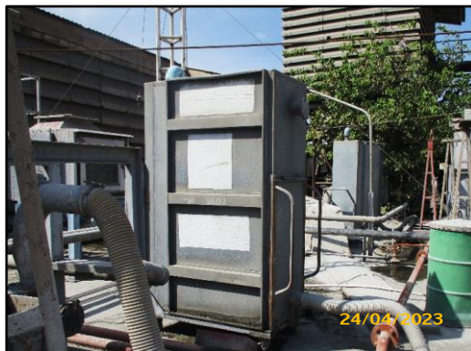
ภาพที่ 2.10 ระบบ Activated carbon
