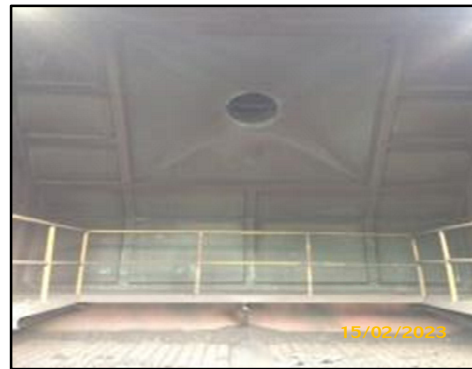
ภาพที่ 3.68 การทำ Hood คลุมอ่างเทเชื้อเพลิง
