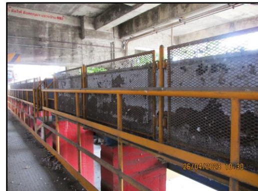
ภาพที่ 2.13 ระบบสายพ่นแบบปิดสำหรับลำเลียงฝุ่น จาก SP Boiler และ Precipitation Chamber
