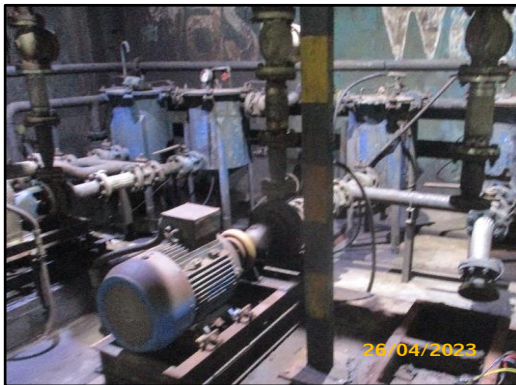
ภาพที่ 2.15 ระบบสูบน้ำกลับเข้า Silo
