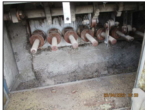
ภาพที่ 3.85 Casing ทุ้มชุด Hammering Equipment ในหม้อไอน้ำ
