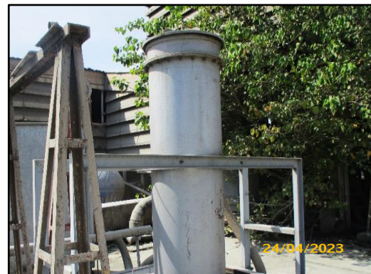
ภาพที่ 2.10 ระบบ Activated carbon
