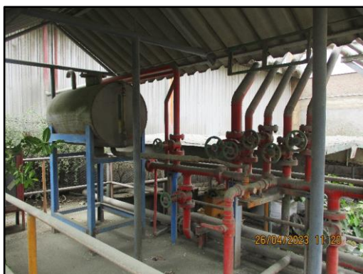
ภาพที่ 2.49 อุปกรณ์ป้องกันและระงับอัคคีภัยประจำบริเวณถังเก็บของเสียที่เป็นของเหลว
